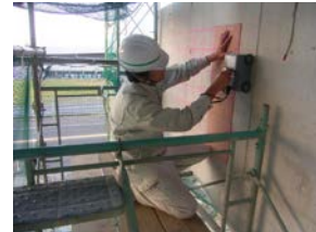
③非破壊検査・耐震診断 (鉄筋探査、超音波探傷 etc)
