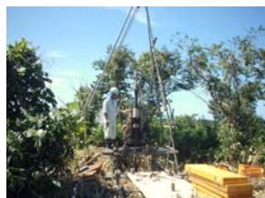
⑪地質調査ボーリング
