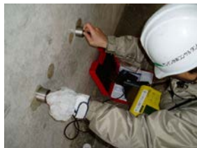
①コンクリートひび割れ診断
