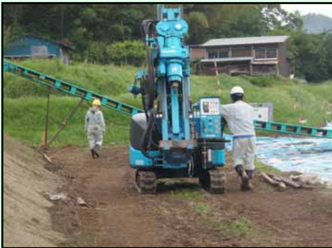
写真-1 自走式による移動状況
