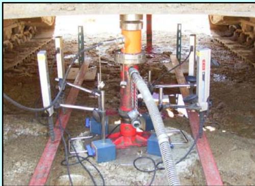
地盤の平板載荷試験
