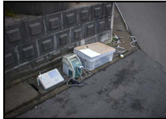
振動調査状況
