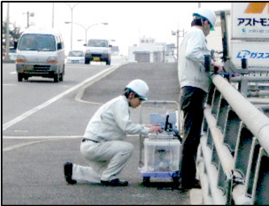
作業スペースは1×2m程度。歩道で十分。
