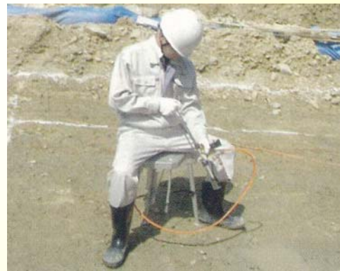
簡易支持力試験機「エレフット」 試験実施状況
